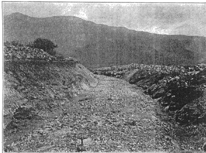
Von der Usambarabahn: Ein Einschnitt.
