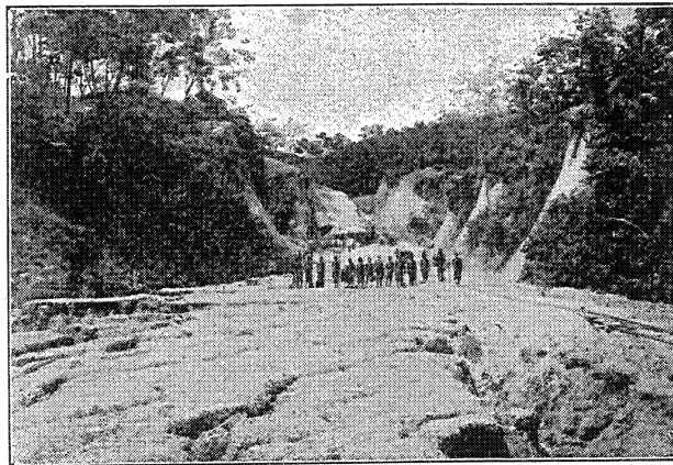
Neu-Guinea. Eingeborene beim Straßenbau auf der Gazelle-Halbinsel.
